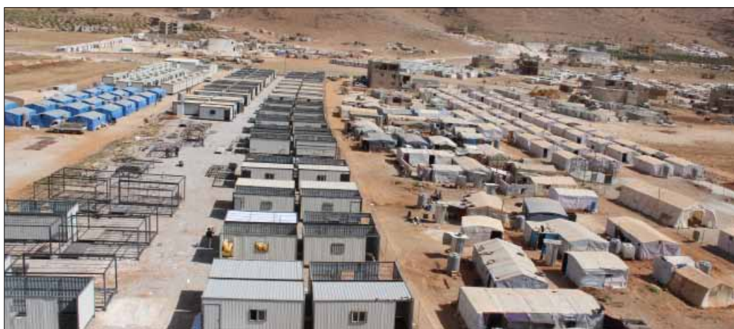
ورشة بناء الكرافانات في عرسال (الأخبار)
